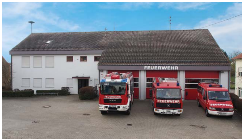
Feuerwehrhaus der Abt. Heilbronn-Sontheim Auf dem Bau 6
