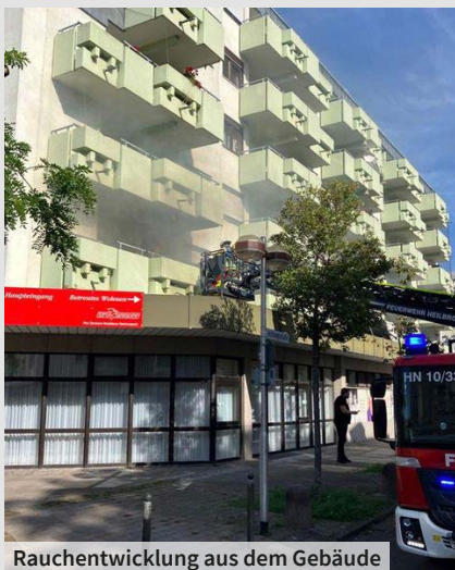
Rauchentwicklung aus dem Gebäude
