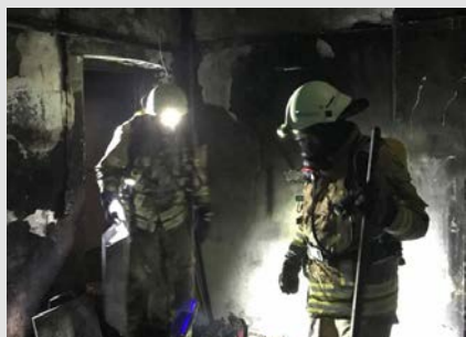
Ausräumen der Kellerräume nach dem Brand
