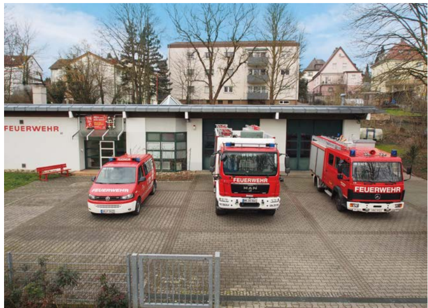
Feuerwehrhaus der Abt. Heilbronn-Frankenbach im Riedweg 37
