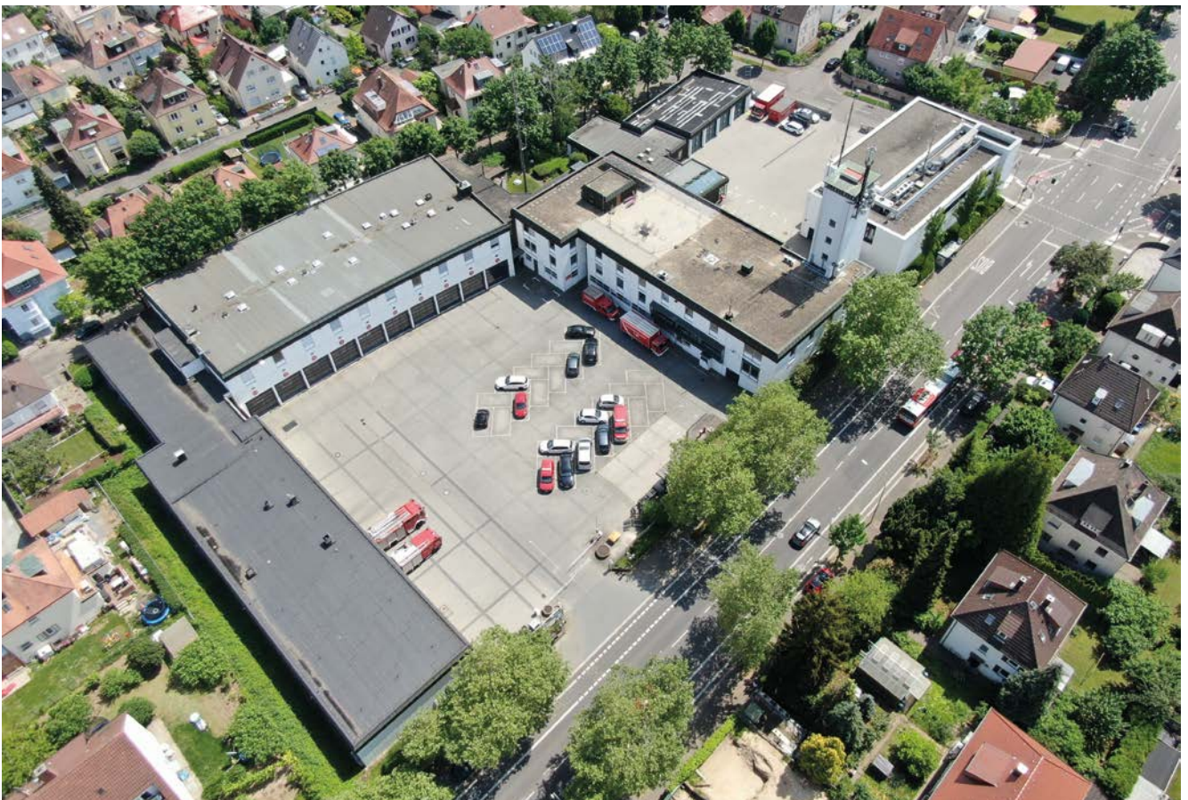
Aufnahme der Hauptfeuerwache Heilbronn mit einer Drohne
