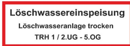
Kennzeichnung der Einspeisestelle bei Löschwasseranlagen „trocken“.
