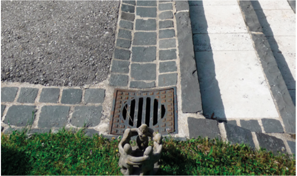
Abb. 90: Offene Mulden-Abflüsse und Aufkantung an einem Hof halten das Wasser vom Haus fern.
